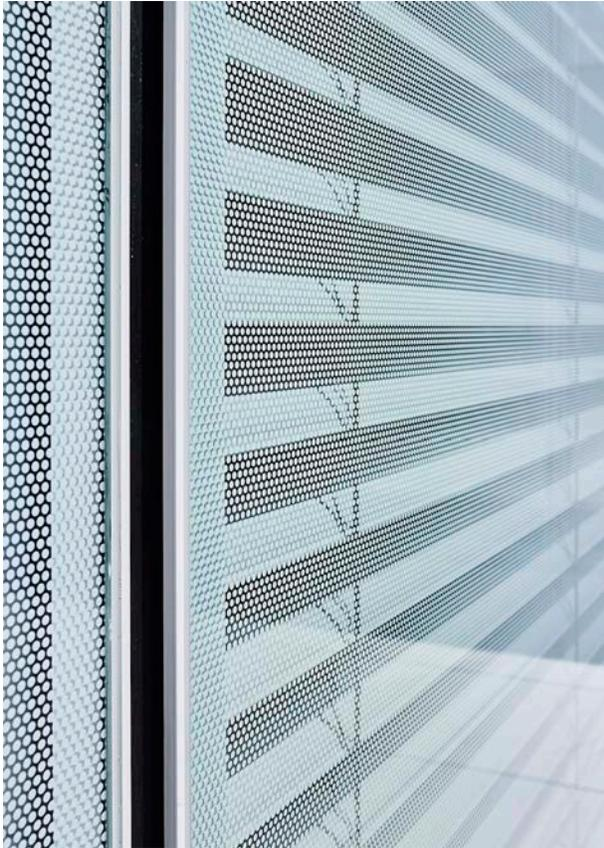
Dietro la lastra isolante esterna stampata con una griglia di punti, l'irraggiamento solare può essere regolato in base alle esigenze mediante una tenda veneziana.
