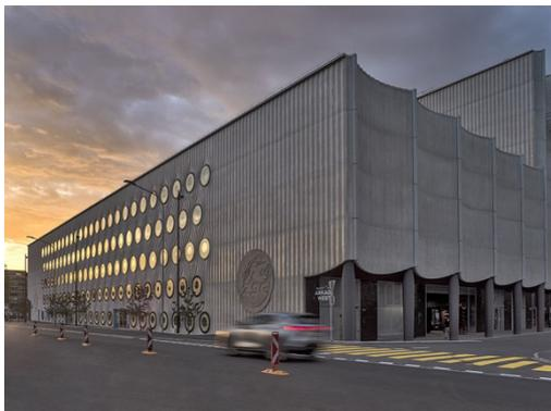
*Après seulement trois ans de travaux, la Swiss Life Arena à Zurich Altstetten est l'un des sites sportifs et événementiels les plus modernes d'Europe et l'un des plus grands projets de construction de la ville. Cet ouvrage marquant se caractérise par une façade d'aspect textile en béton coulé sur place. Photographie: © R&D Dürr*
