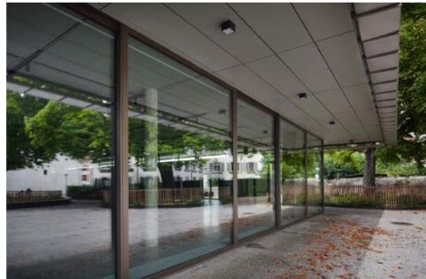
*Une liaison esthétique et technique entre le bâtiment existant et la nouvelle construction. Les portes et les vitrages fixes ont été réalisés avec le système de profilés en acier Forster unico, et ce aussi bien dans le bâtiment du théâtre (à gauche sur la photo de gauche) que dans la salle des fêtes adjacente. Photos : © Damian Poffet*
