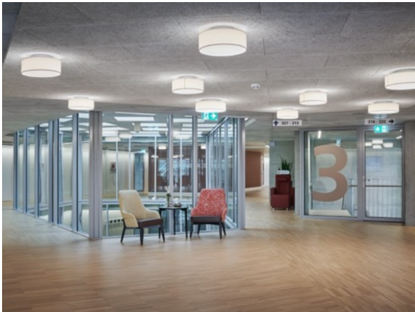
Die als geschlossene Rundgänge angeordneten Flure bieten den Bewohnenden intuitive Orientierung, während die grosszügige Verglasung zum Lichthof mit forster thermfix vario EI60 für maximale Tageslichtzufuhr auf den Etagen sorgt. Fotos: © Damian Poffet
