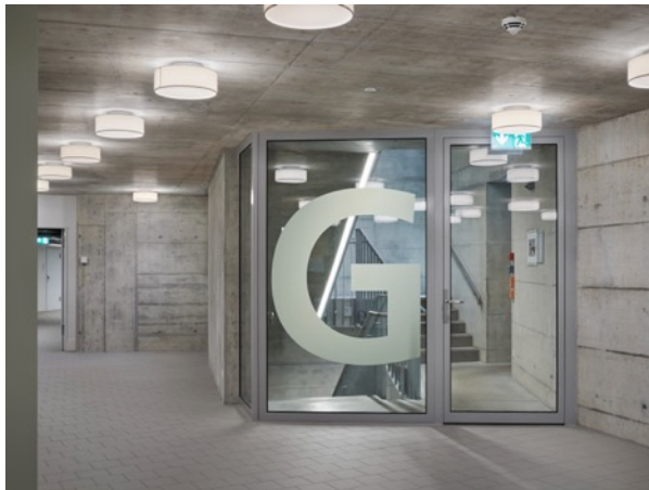
Die ein- und zweiflügeligen Brandschutztüren mit forster fuego light EI30 und EI60 bieten im Treppenhaus zuverlässigen Schutz und fügen sich harmonisch in das Gestaltungskonzept ein. Fotos: © Damian Poffet
