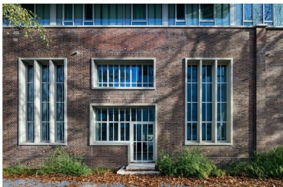
*Les sections de profilé ultrafines font de forster unico xs la solution à isolation thermique idéale pour les rénovations réalisées dans le respect des monuments historiques. Photo : © Jens Kirchner Architekturfotografie*
