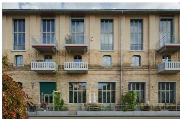
*Afin de satisfaire les exigences élevées du maître d'ouvrage en matière de durabilité et de viabilité future, des systèmes de fenêtres et de portes à haute efficacité énergétique forster unico Hi en acier recyclable ont été installés au rez-de-chaussée des bâtiments et dans les maisons de ville. Photos : © Damian Poffet*
