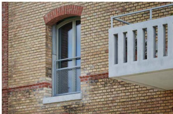
*Pour les maisons de ville de la Lokstadt, l'esthétique de briques des ouvrages industriels existants a pu être partiellement préservée et valorisée avec de nouveaux balcons ainsi qu'avec de nouvelles fenêtres et portes à haute efficacité énergétique. Photos : © Damian Poffet*
