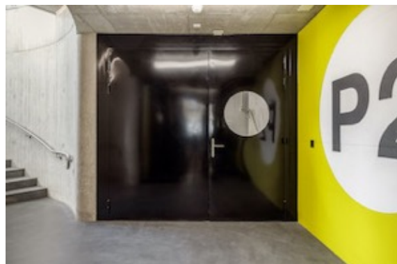
Mit den Systemen forster fuego light (links) und forster presto 50 (rechts) lassen sich ein- und zweiflügelige Brandschutztüren auch mit Vollblech-Flügeln konstruieren. Fotos: © LOSYS GmbH
