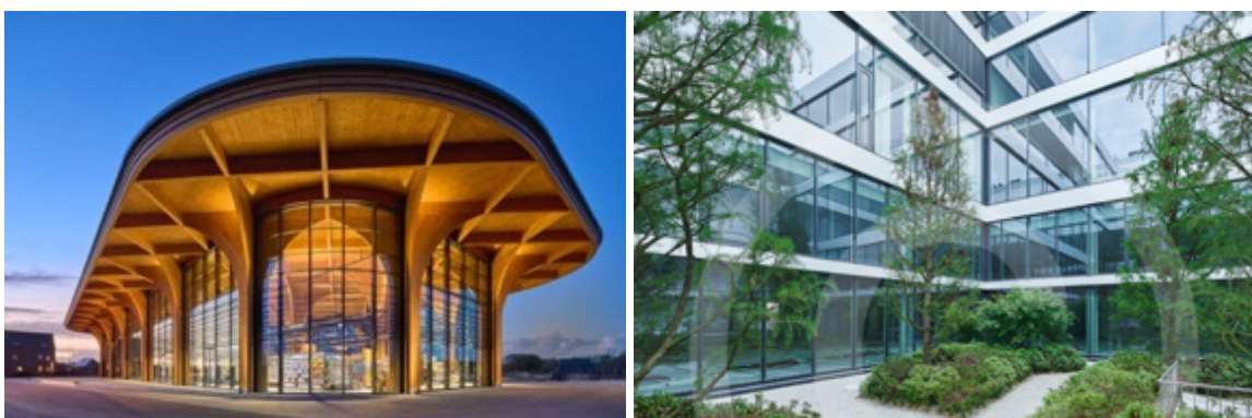
Wärme gedämmte Vorhangfassaden mit Brandschutz: Das Profilsystem forster thermfix vario basiert auf einer Pfosten-Riegel Konstruktion und erlaubt mit schlanken Ansichtsbreiten von nur 45 Millimetern eine Vielfalt von grossflächigen Anwendungen. Foto: © Ronald Tilleman (links), © Damian Poffet (rechts)
