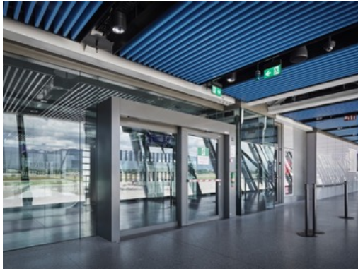
Brandschutz-Schiebetür mit Fluchttürfunktion: Automatische Schiebetüren mit forster fuego light EI30 mit integrierter Fluchttür und Panik-Druckstangen ermöglichen im Notfall eine schnelle Evakuierung. Foto: © Damian Poffet
