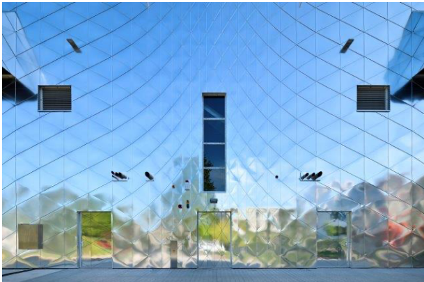
Zehn unterschiedlich dimensionierte Aluminium-Dreiecke sind so angeordnet, dass sich die Verläufe der Schindeln als Wirbel auf der Fassade abbilden. Foto: Ralf Dieter Bischoff
