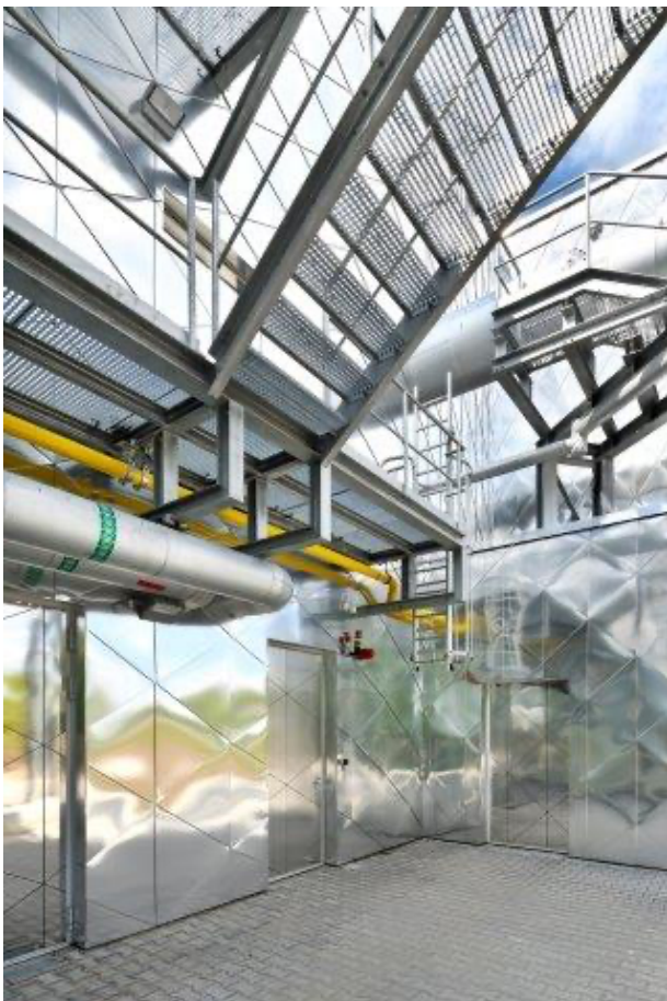
Technische Bestandteile des Kraftwerks, Leitern und Leitungen liegen außen. Die funktionale Infrastruktur des Gebäudes, wie Fallrohre, wurden in der VHF in die Dämmebene integriert. Foto: Ralf Dieter Bischoff
