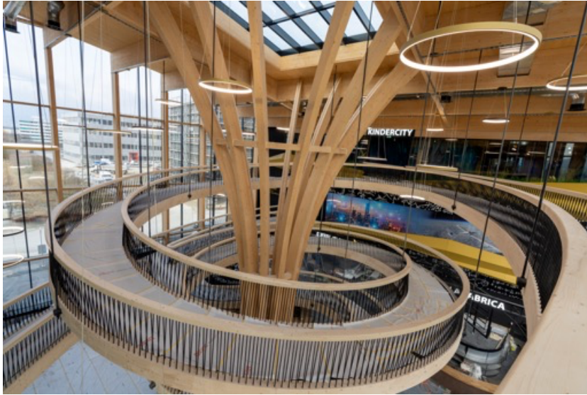
Das Zentrum des verglasten Atriums bildet eine 14 Meter hohe, 150 Meter lange, aus regionalem Holz gefertigte Rampe. © EXPLORiT
