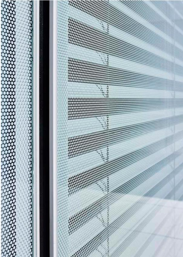
Derrière la vitre externe ornée d'un quadrillage de points se trouve un store à lamelles qui permet de réguler, si nécessaire, le rayonnement.
