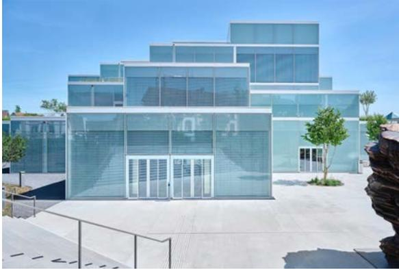
Le quadrillage en béton apparent et la façade double-peau fermée définissent l'esthétique du SQUARE.
